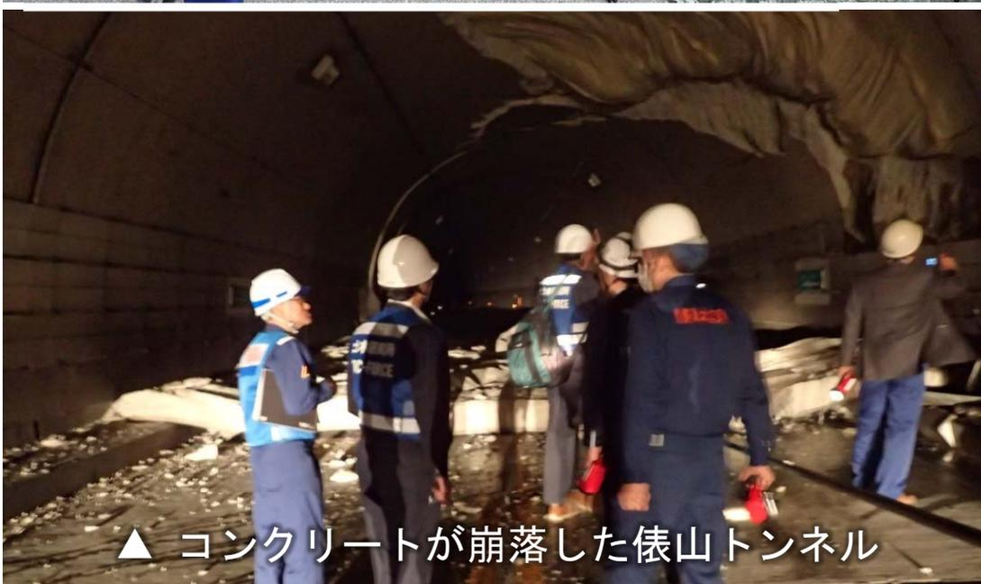
▲ コンクリートが崩落した俵山トンネル
