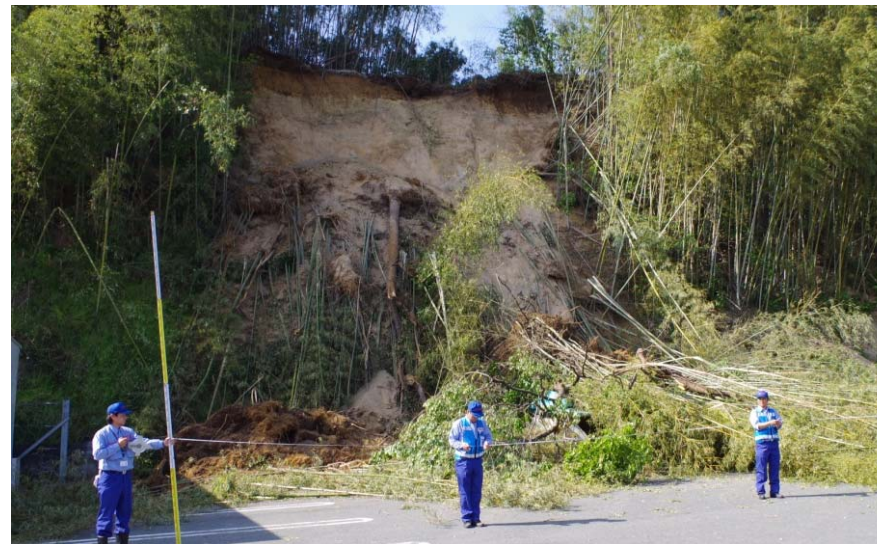
▲ 法面崩壊箇所を調査
