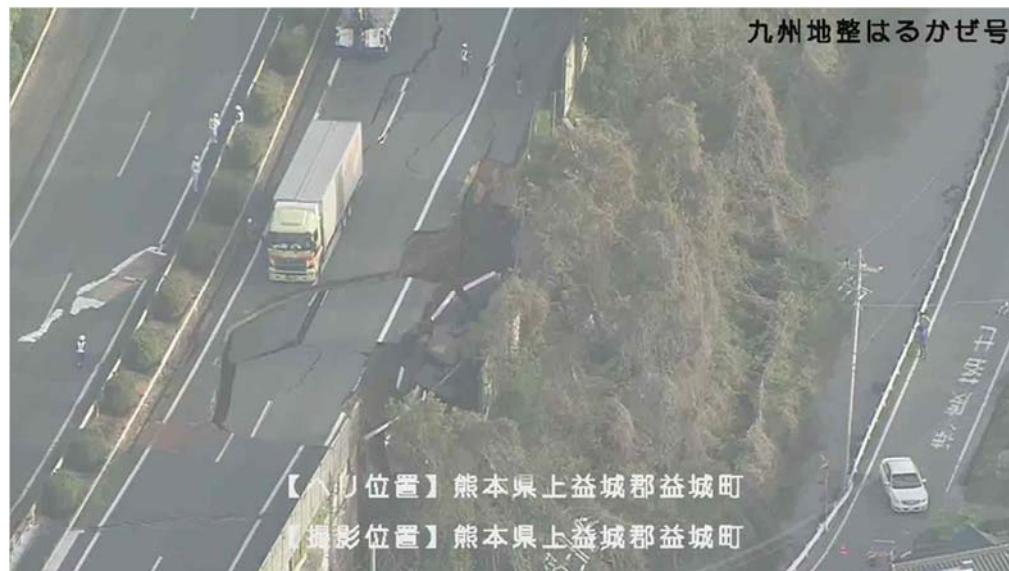
▲ 九州自動車道の陥没
