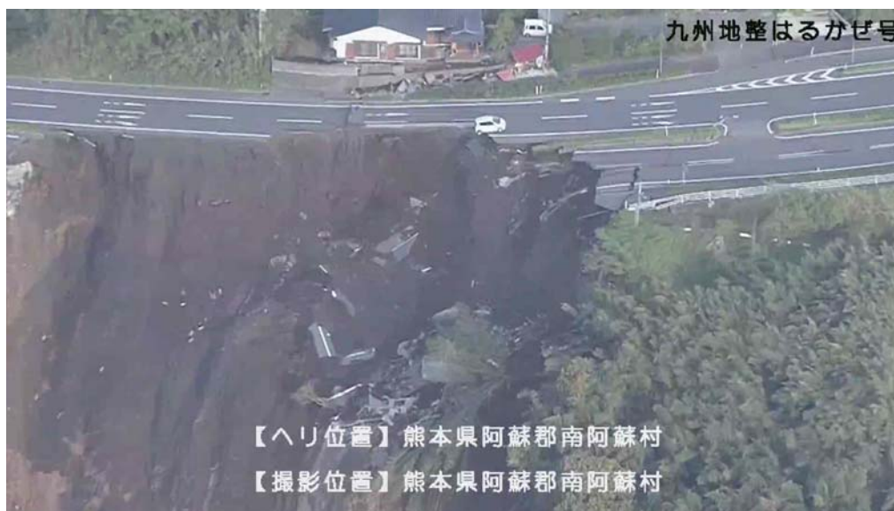
▲ 大規模な道路崩壊 車両や家屋が二次被害
