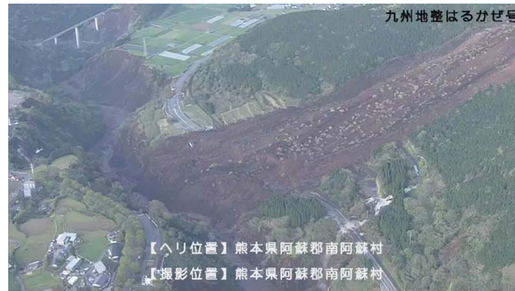
▲ 土石流による道路寸断、橋梁の喪失
