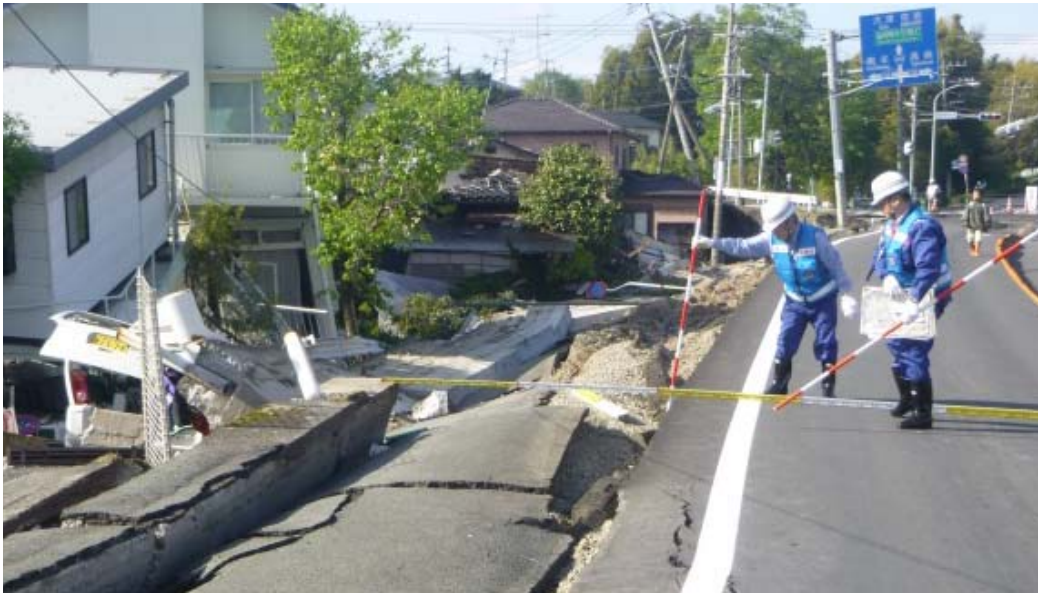
▲ TEC-FORCEが道路の被災状況を調査
