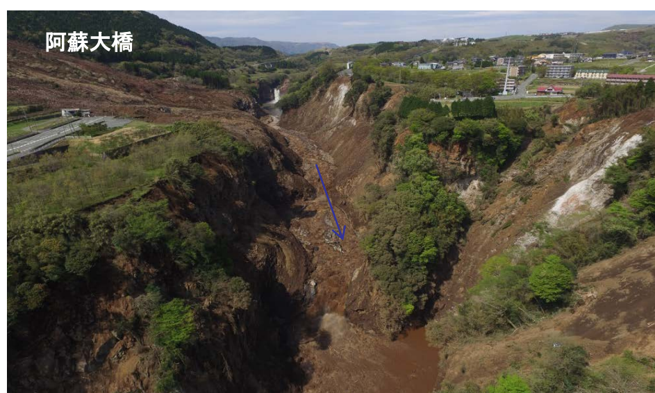
▲ 土砂崩落箇所を調査
