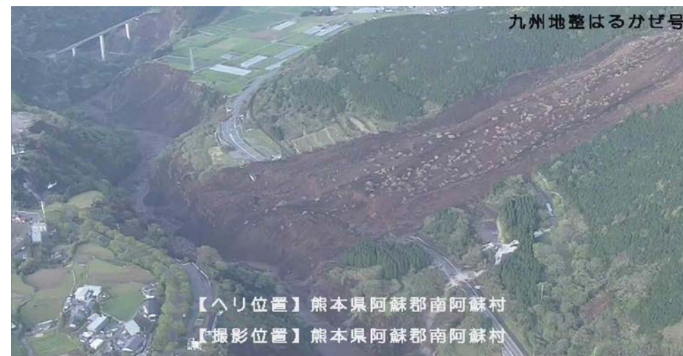
▲ 土石流による道路寸断、橋梁の喪失
