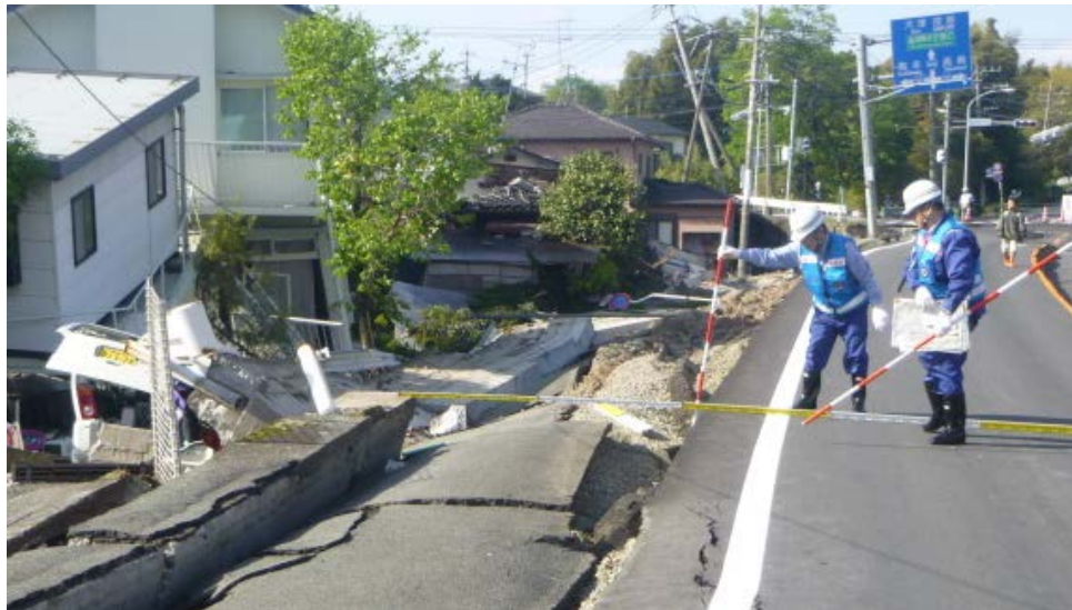
▲ TEC-FORCEが道路の被災状況を調査
