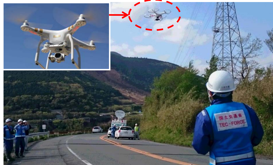
▲ ドローンが離陸し崩落箇所へ急行
