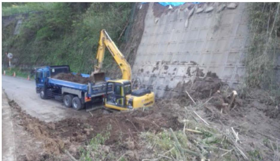
▲バックホウにより崩落土砂を撤去
