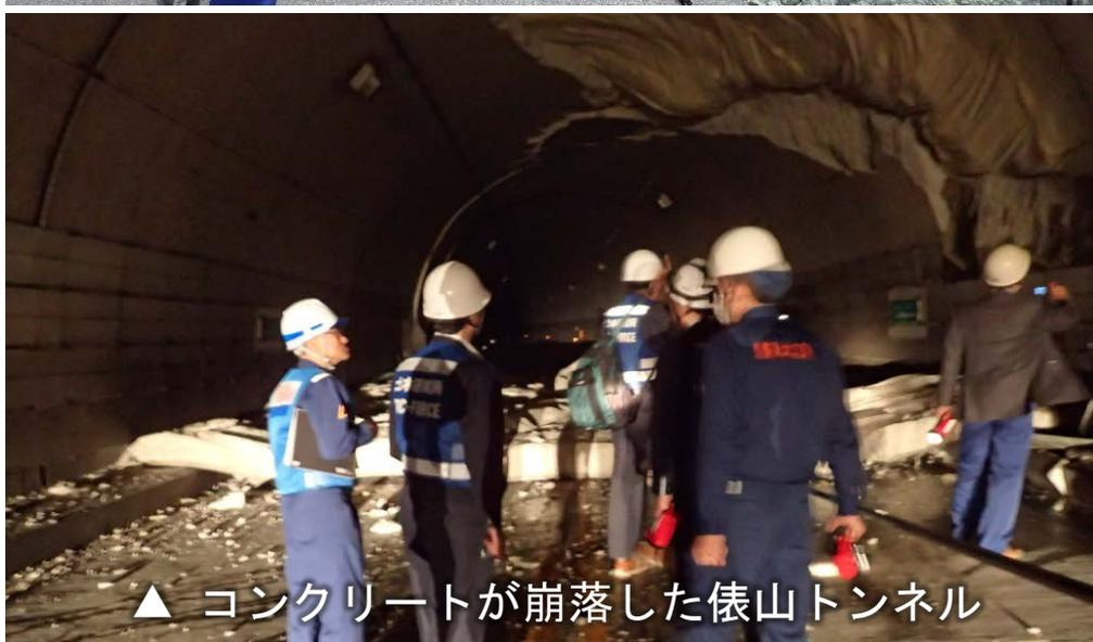
▲ コンクリートが崩落した俵山トンネル
