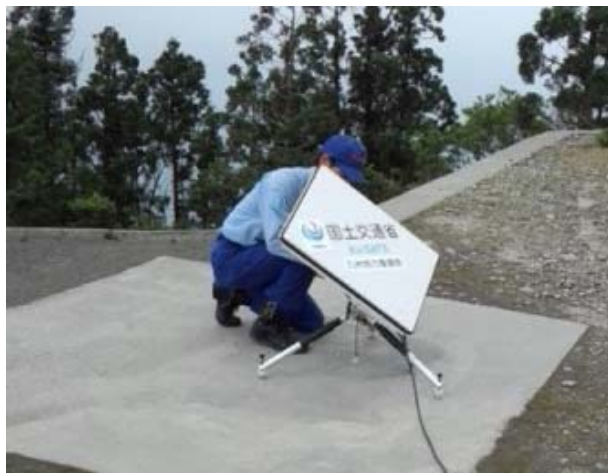
▲Ku-SAT※の設置状況 ※Ku-SAT…衛星小型画像伝送装置
