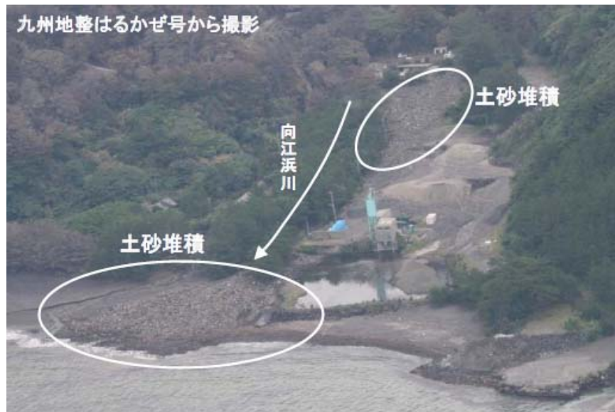
▲ 土石流の発生状況（向江浜川）
