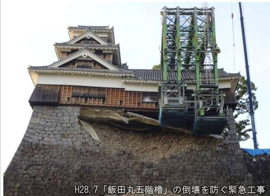
H28. 7 「飯田丸五階櫓」の倒壊を防ぐ緊急工事
