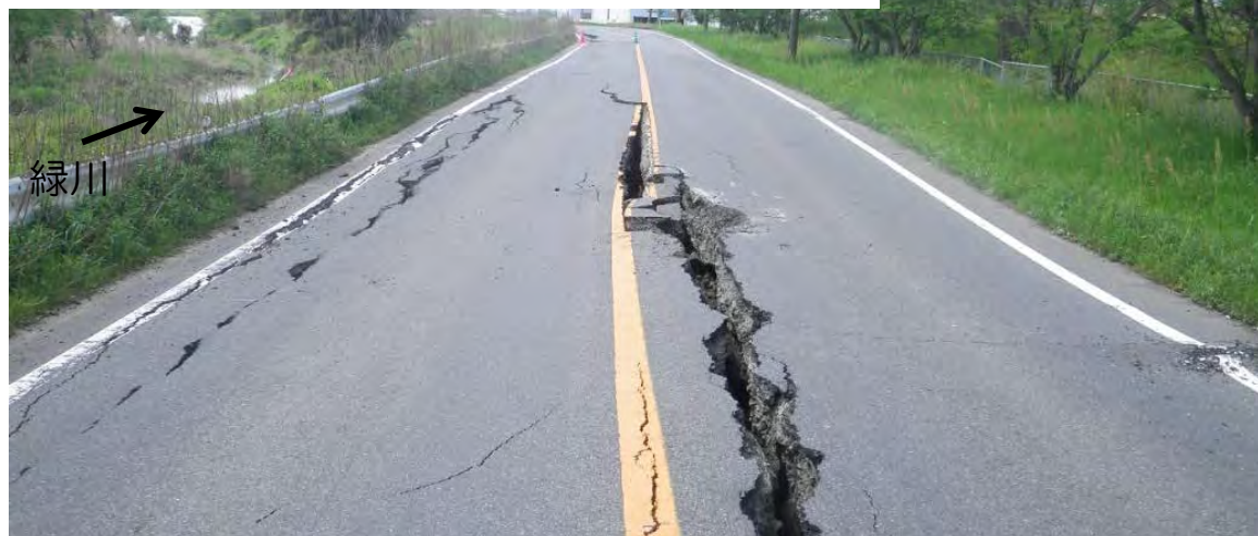
《緊急復旧後》4/30（緑川右岸9k200）
