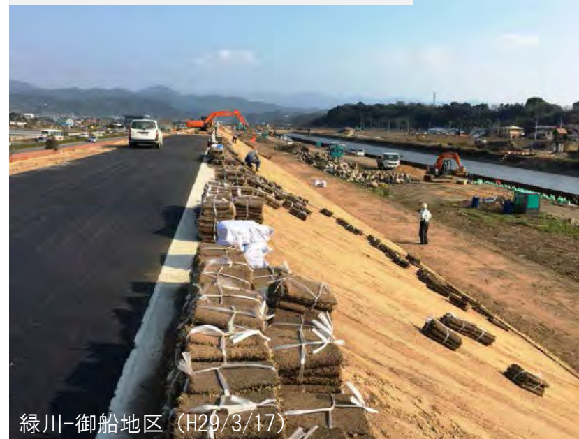
変状が発生した堤防の再構築を実施中 (張芝)
