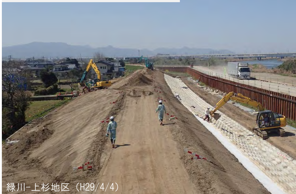
変状が発生した堤防の再構築を実施中 (接続ブロック及び盛土)
