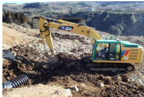
排水工の整備状況
