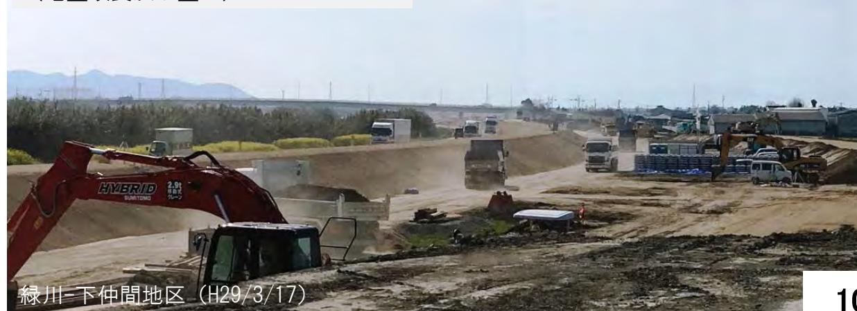
変状が発生した堤防の再構築を実施中 (地盤改良及び盛土)
