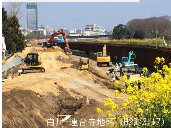
変状が発生した堤防の再構築 を実施中 (地盤改良及び盛土)
