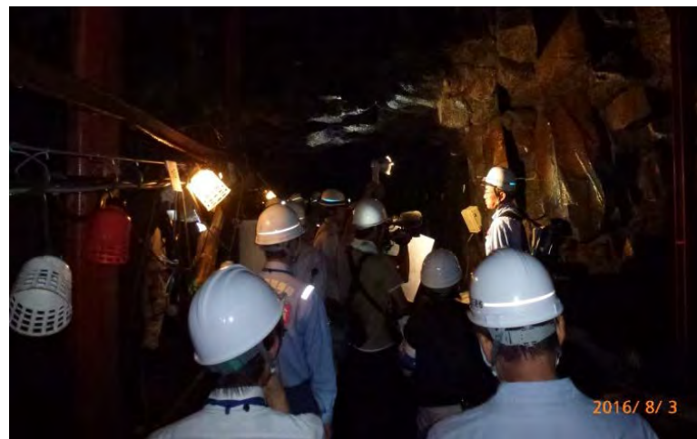
横坑の調査状況(H28.8.3)
