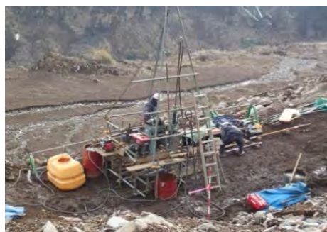
地質調査状況
