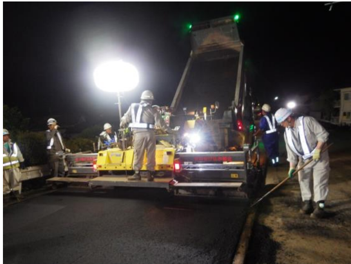
夜間作業での アスファルト フィニシャーに よるアスファルト 舗装作業
