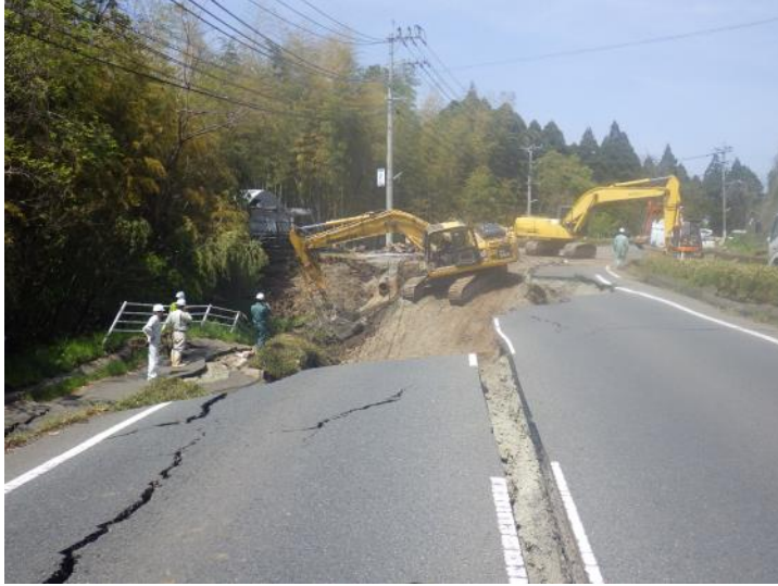
バックホウにて 崩壊箇所の 復旧作業開始
