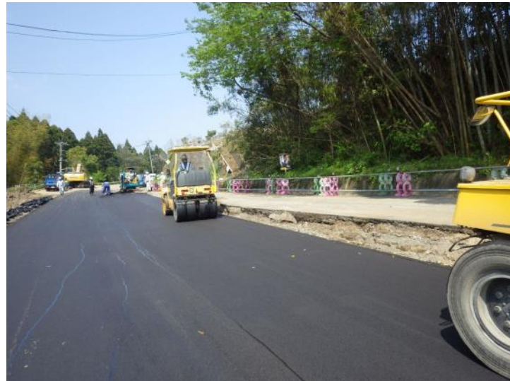
タイヤローラに よる舗装転圧 仕上げ
