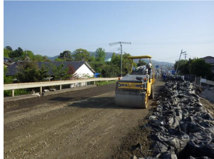
路面復旧のため 振動ローラにて 路盤転圧作業
