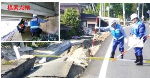
▼護岸背面の沈下状況を調査（港湾調査班）
