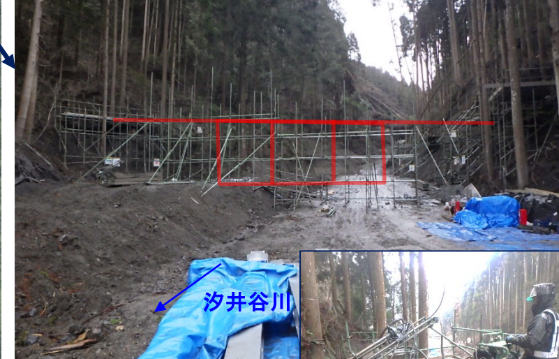
アンカー削孔中
