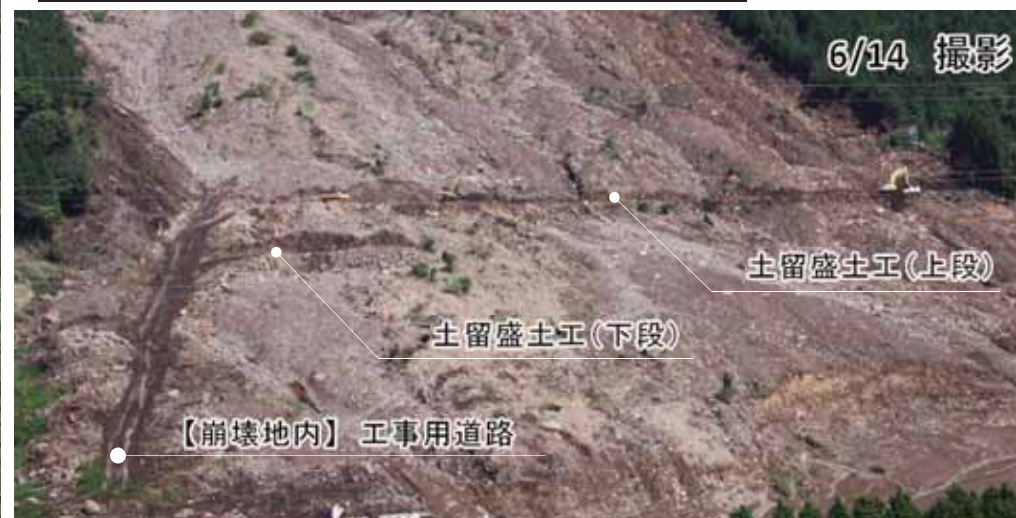
土留盛土工の造成（地盤改良）
