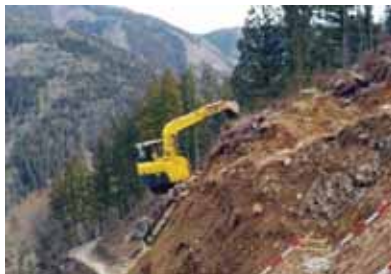
高所法面掘削機
