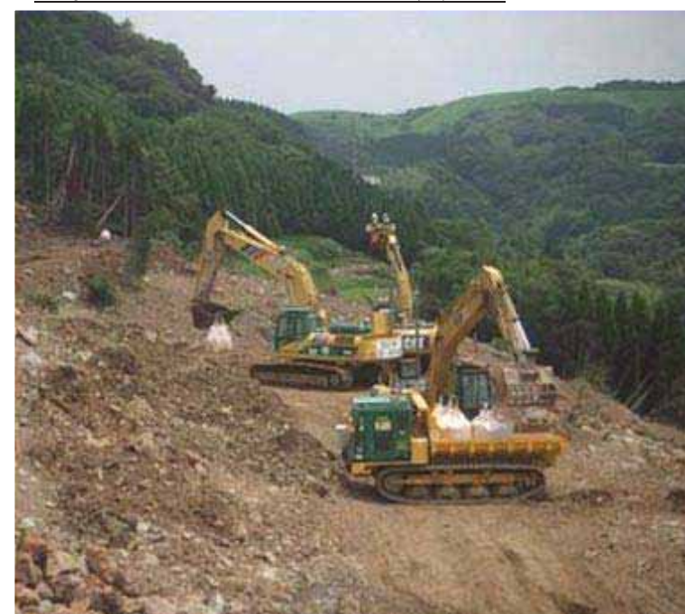
土留盛土工の造成（地盤改良）
