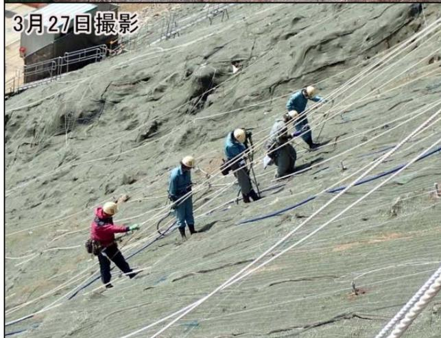
法面全11段の最下段の掘削に着手しています。
