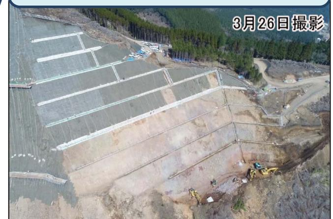
土留盛土下部では崩壊部の構造物構築を実施しています。
