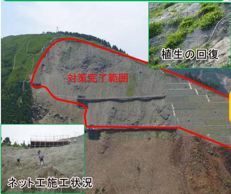
大分側凸部 法面11段目(最下段)／全11段 緩み土塊の除去後、アンカー工を施工しています。
