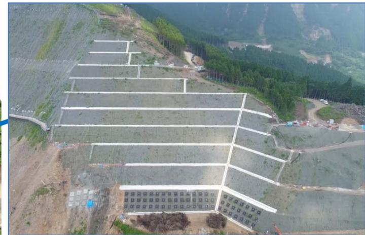
大分側凸地形部: 緩み土塊の除去後、法面对策完了
