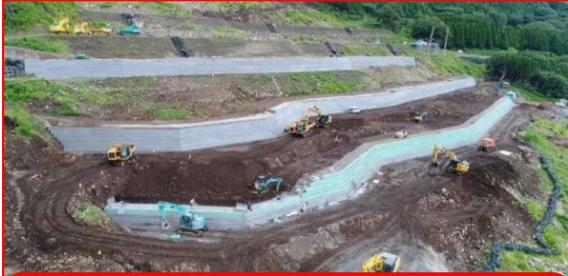
土留盛土下部(鋼製土留工): 全4段のうち3段目まで対策完了
