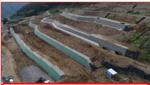
土留盛土下部(鋼製土留工): 施工中
