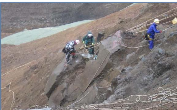
斜面内の巨石の除去: 施工完了
