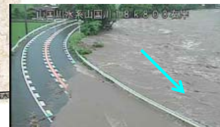
山国川右岸18k800付近 (浸水面積：約1.4ha)
