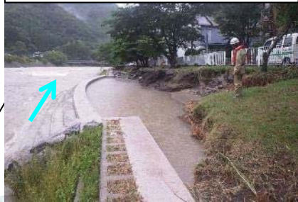
山国川右岸26k400付近 護岸損壊 L=約20m 7月11日18:00完了
