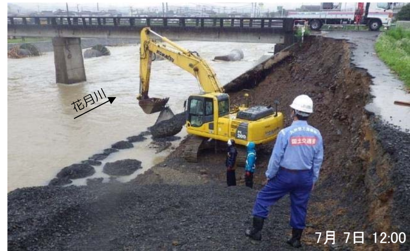
緊急復旧状況
