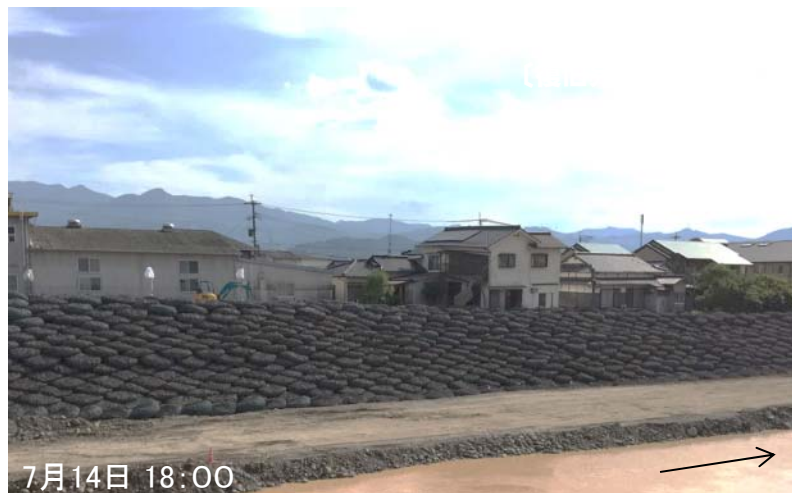
緊急復旧状況
