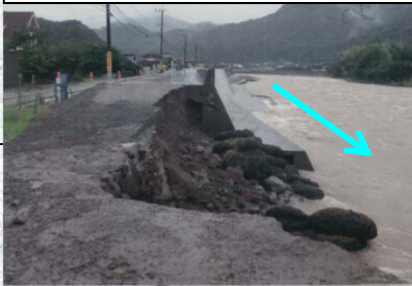
山国川右岸19k800付近 堤防洗掘 L=約20m 7月6日16:00完了
