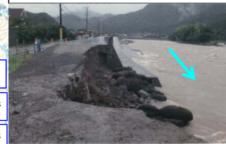
山国川水系山国川 右岸 19.8k付近 堤防洗掘
