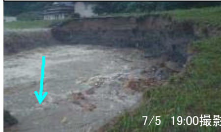
筑後川水系花月川 右岸 0.5k付近 護岸損壊
