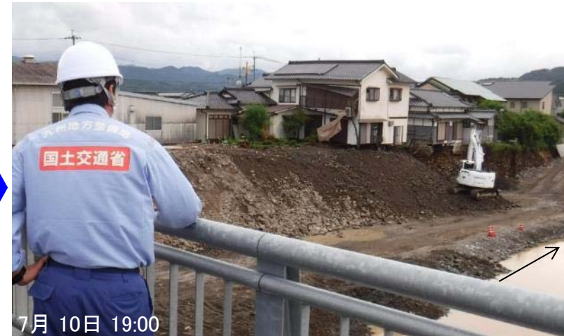
緊急復旧状況
