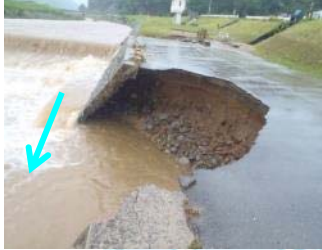
遠賀川水系彦山川 左岸 31.5k付近 堤防洗掘
