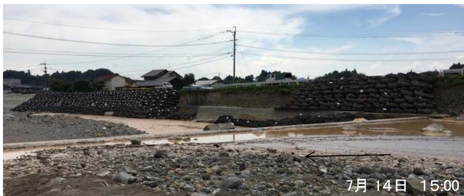
緊急復旧状況
