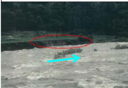
山国川左岸23k200付近 護岸損壊 L=約100m 7月11日16:00完了
