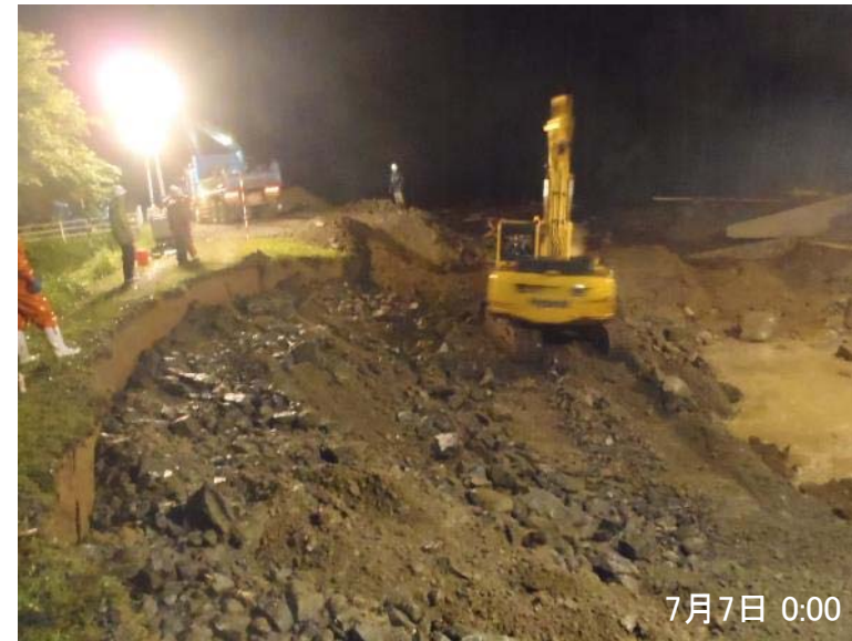
緊急復旧状況
