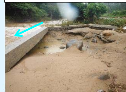
遠賀川水系彦山川 左岸 31.2k付近 護岸崩壊
