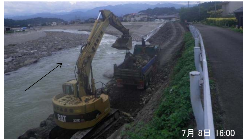
緊急復旧状況
