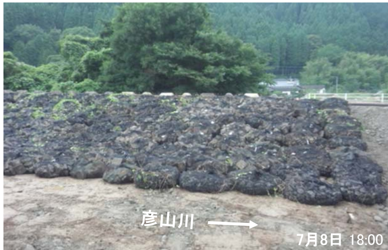
緊急復旧完了
