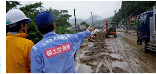
▲ 道路の被災調査
