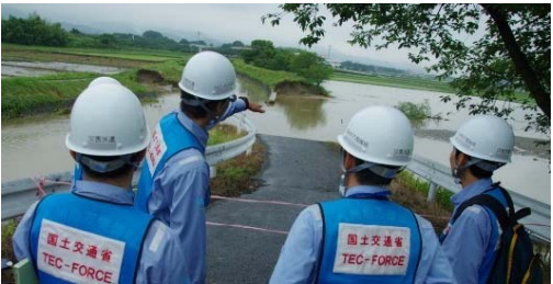
▲ 河川堤防の被災調査
