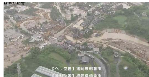
▲ 防災ヘリからの被災調査
