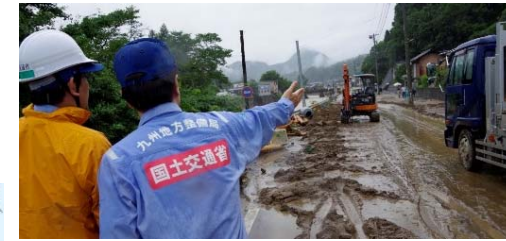
▲ 道路の被災調査
