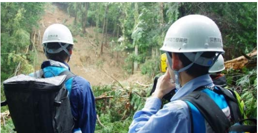
▲ 砂防の被災調査
