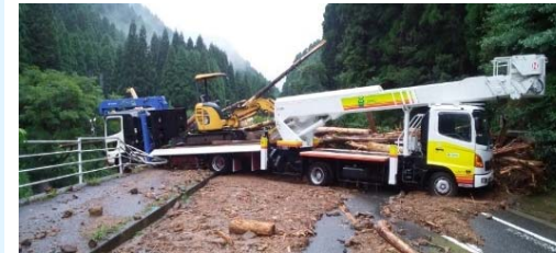
▲ 道路の啓開作業
