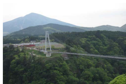
大分 九重夢大吊橋
