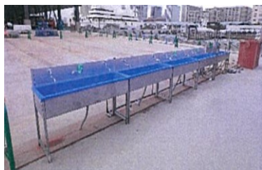
現場の手洗い場所の増設
