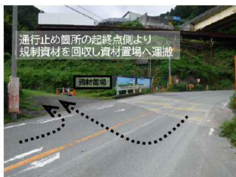
規制資材の回収・運搬状況(平時)
