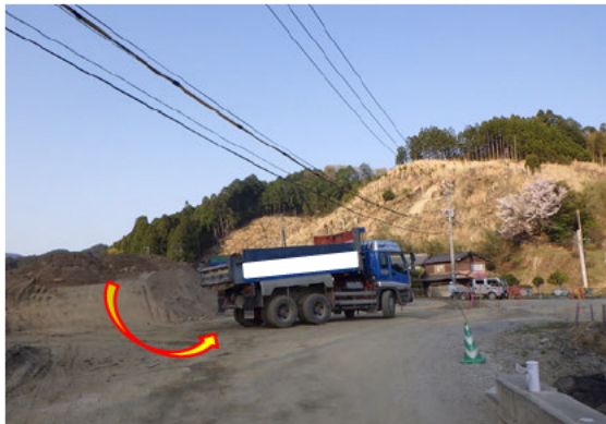
DTは残土を仮置きし、荷台が下がりきらない状況で走行
