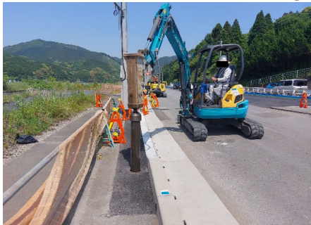
ガードパイプ支柱建て込み状況
