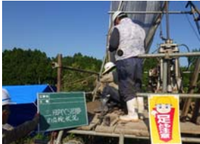
ボーリング足場及び三脚やぐらの点検表
