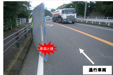
強風で飛散防止ネットが車道へ移
