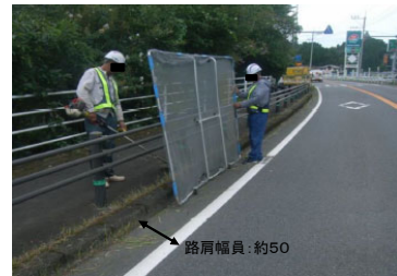
強風で飛散防止ネットが車道へ移
