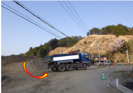
DTは残土を仮置きし、荷台が下がりにくい状況で走行
