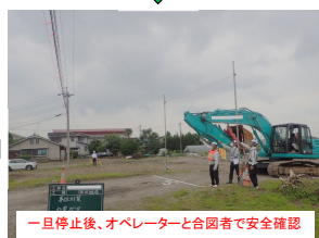
一旦停止後、オペレーターと合図者で安全確認
