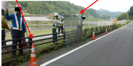
赤色三角コーンを路肩に設置し、通行車両への注意喚起
