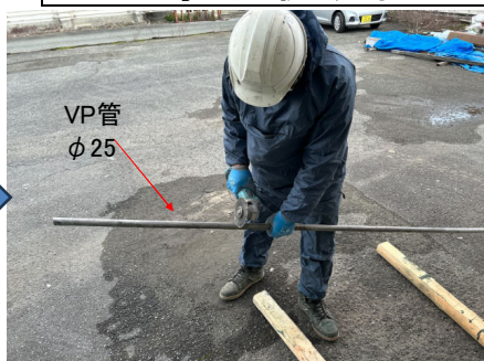
廃材コンテナに入れるためVP管をディスクグラインダーでカットしていた
