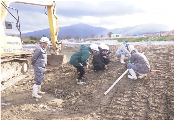
坂路勾配確認状況(1)
