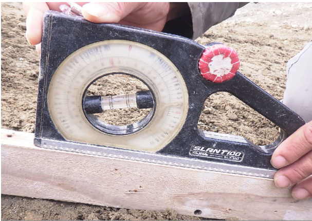
坂路勾配確認状況(2)
