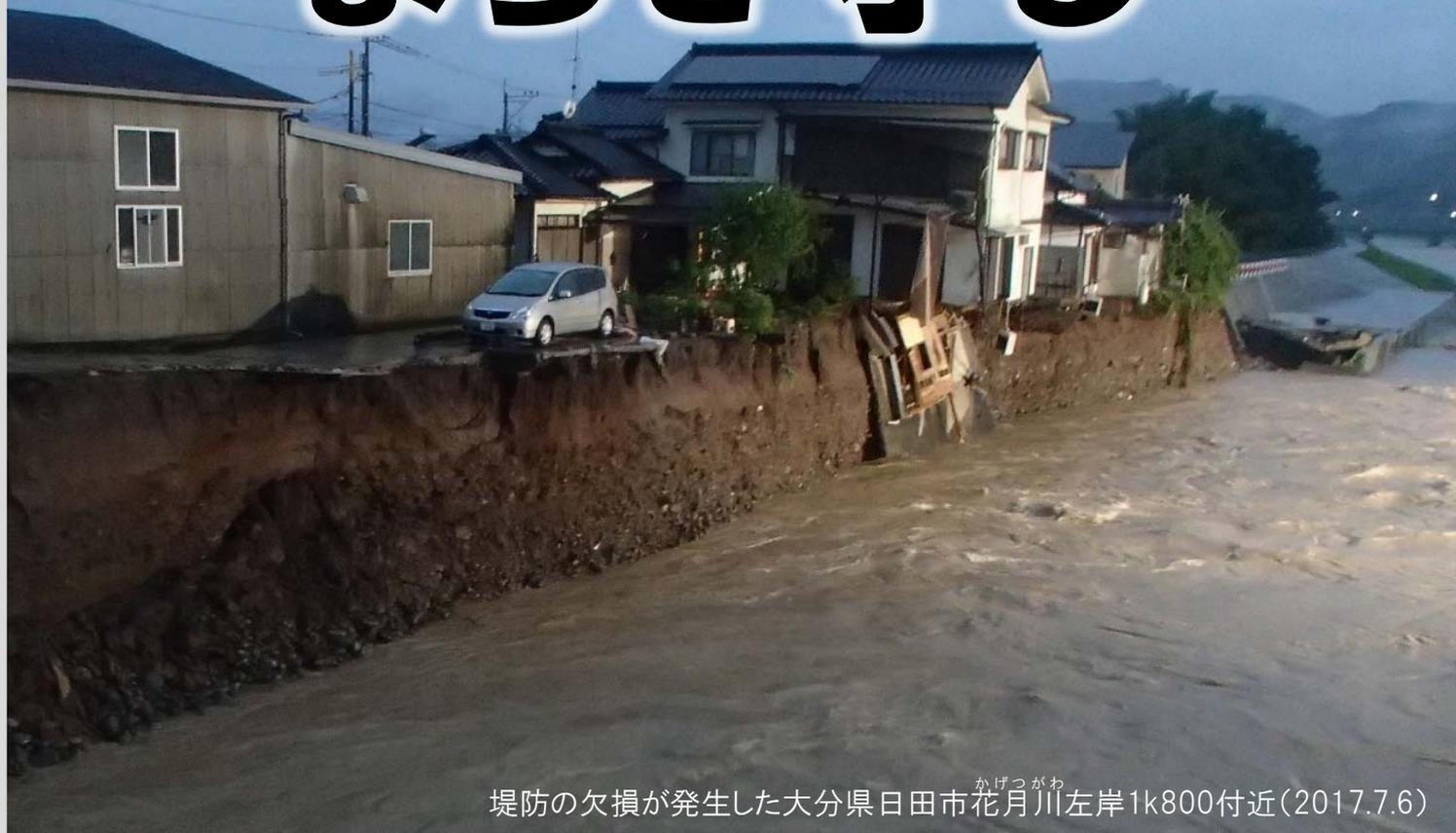
堤防の欠損が発生した大分県日田市花月川<sup>かげつがわ</sup>左岸1k800付近(2017.7.6)
