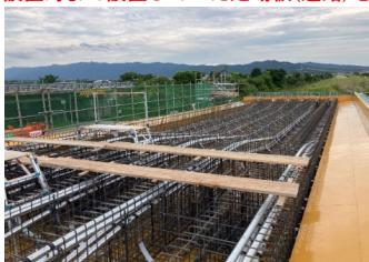
張出床版下縁線上に足場板を設置し、橋軸直角方向の鉄筋を2人以上で間配する
