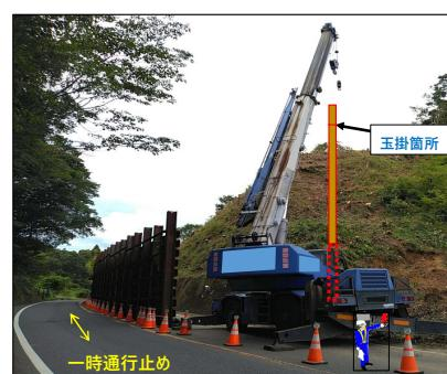
・根元部の切断時に一時的に全面通行止めを行い第3者への直接被害を回避する。
