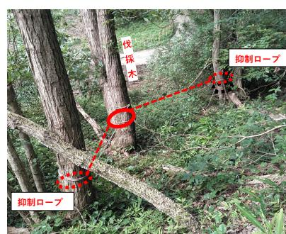
・根元部切断時の転倒方向を抑制するため、根元部分にロープを括り付ける
