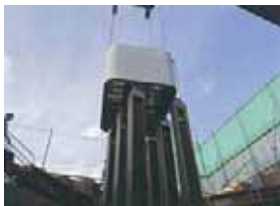
橋梁下部工 橋脚部の埋設型枠
