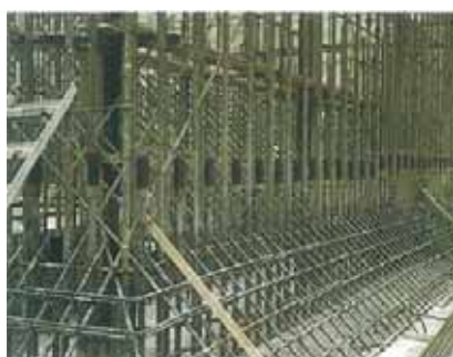
地下構造物施工例
