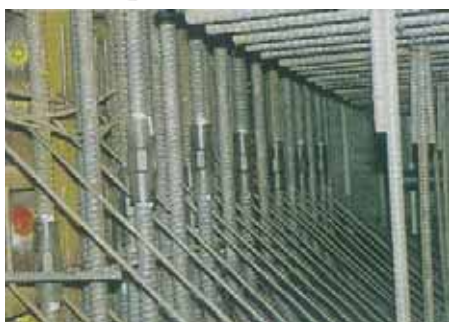
地下構造物施工例
