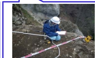
高所斜面上の臨場検査
