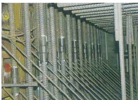
地下構造物施工例
