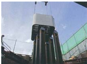
橋梁下部工 橋脚部の埋設型枠
