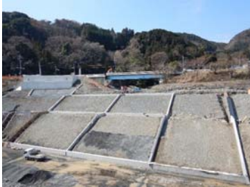
護岸付属物工(横帯工)
