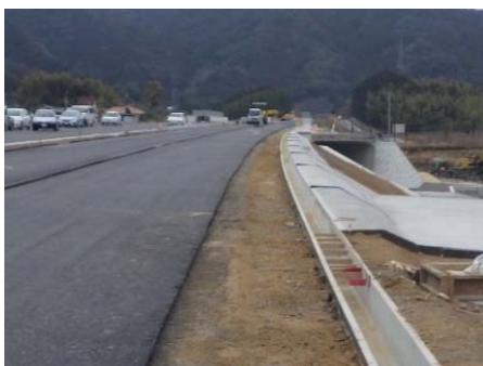
側溝工(U型側溝)
