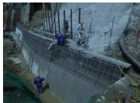
擁壁工 外壁の埋設型枠
