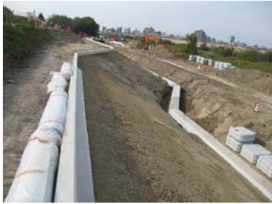
基礎工(護岸) (プレキャスト)
