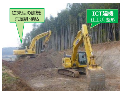
現地状況等に応じて、ICTと従来型の建機を使用
