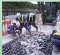
▲ 修繕・耐震補強
