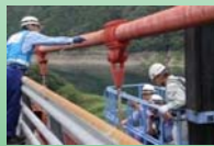
▲ 国道メンテナンス
