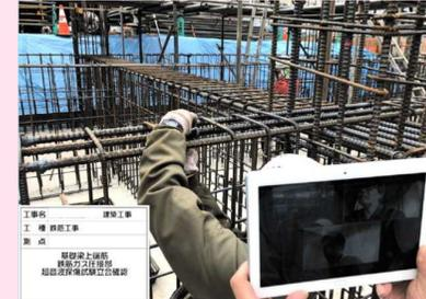
Webカメラを利用した遠隔検査
