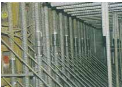
地下構造物施工例
