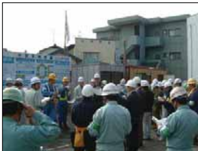
安全パトロールの実施
