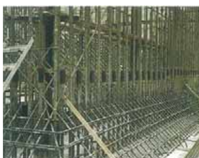
地下構造物施工例
