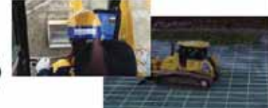
ICT建機による施工
