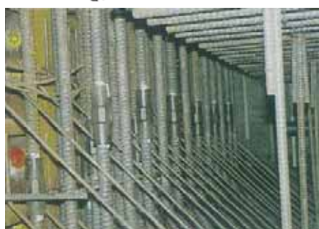
地下構造物施工例
