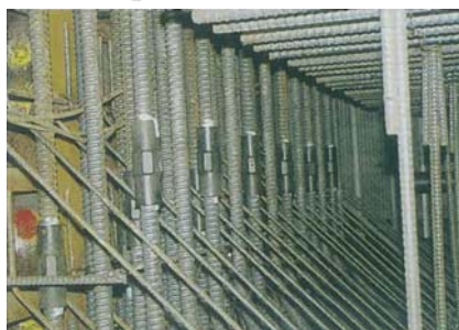
地下構造物施工例
