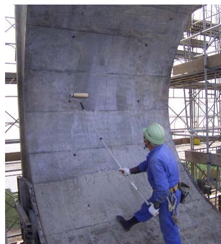
図 6-1 被膜養生剤塗布状況
