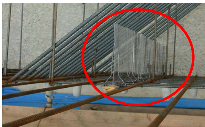
写真 3-1 ひび割れ誘発目地設置状況
