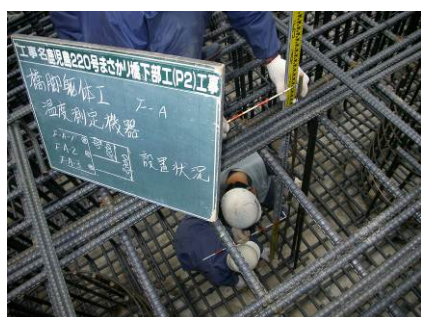
写真 3.7.1 温度測定機器設置例
