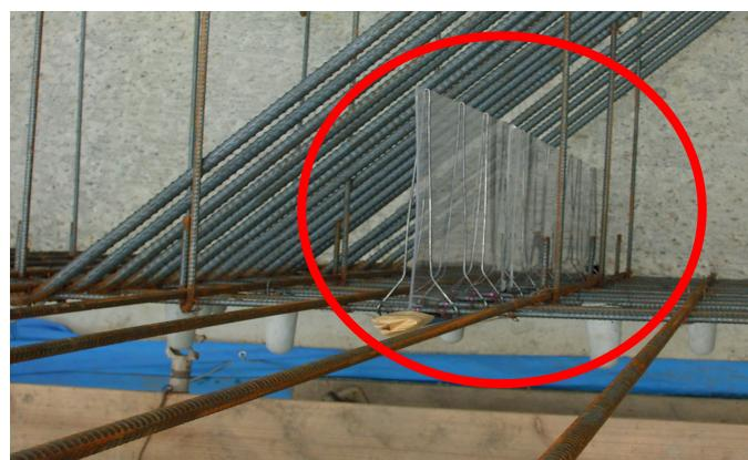
写真3-1 ひび割れ誘発目地設置状況
