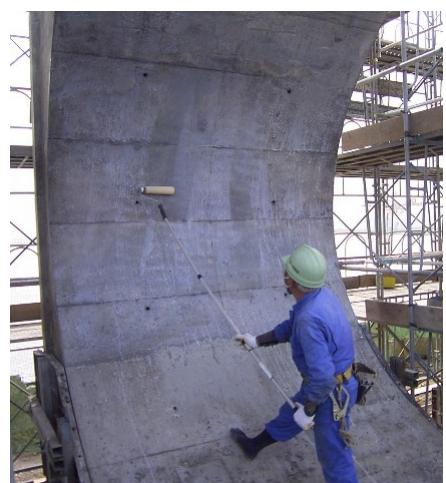
図 6-1 被膜養生剤塗布状況
