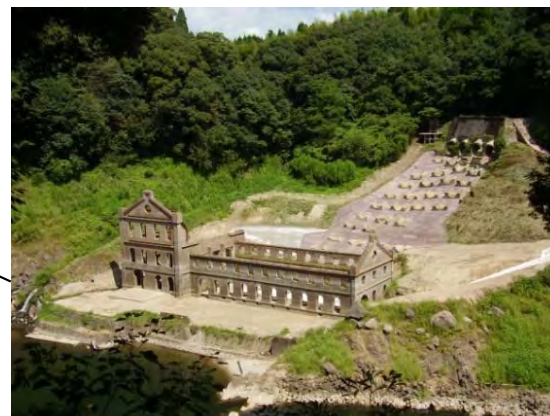
曾木発電所遺構
