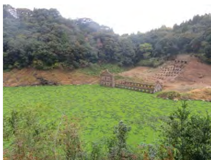
R1年11月曾木発電所遺構付近
