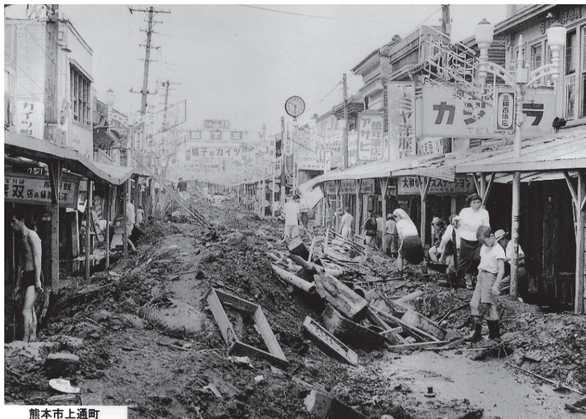
洪水後のヨナの堆積状況(熊本市上通町)
