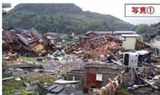
図 2.2.11(1) 球磨川右岸から約50m離れた場所での家屋倒壊(球磨村渡地区)
