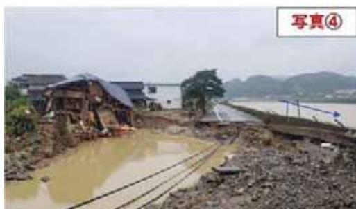
図 2.2.11(4) 堤防の損傷と氾濫流による家屋倒壊が発生(人吉市下薩摩瀬町)
