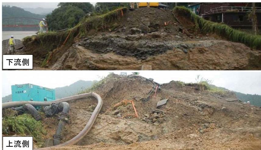
図 3.4.4 堤防決壊箇所の被災断面写真
