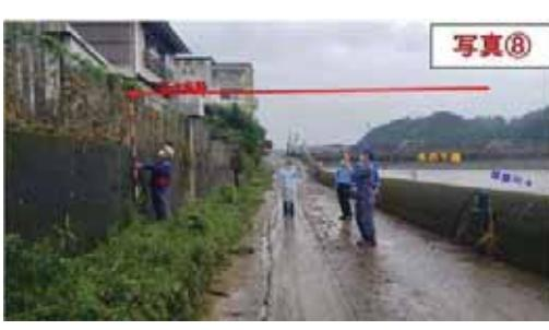
図 2.2.11(8) 堤防を2m程度上回る高さに洪水痕跡を確認(水の手橋下流右岸)
