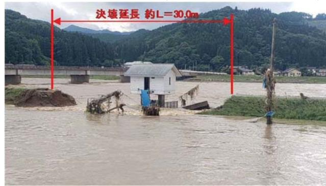
図 2.2.17 八久保排水樋管付近堤防決壊状況(56km4 右岸付近)
