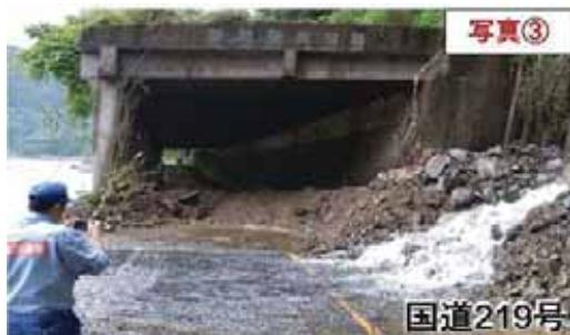
図 2.2.11(3) 土砂流入により国道219号が被災
