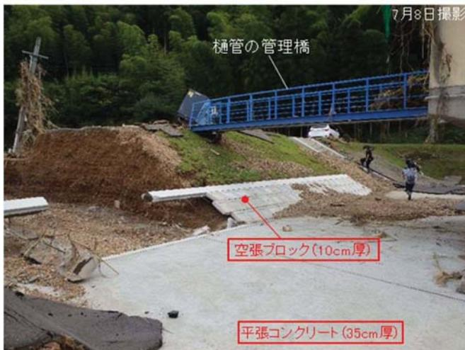
図 3.4.9 川表護岸 被災状況
