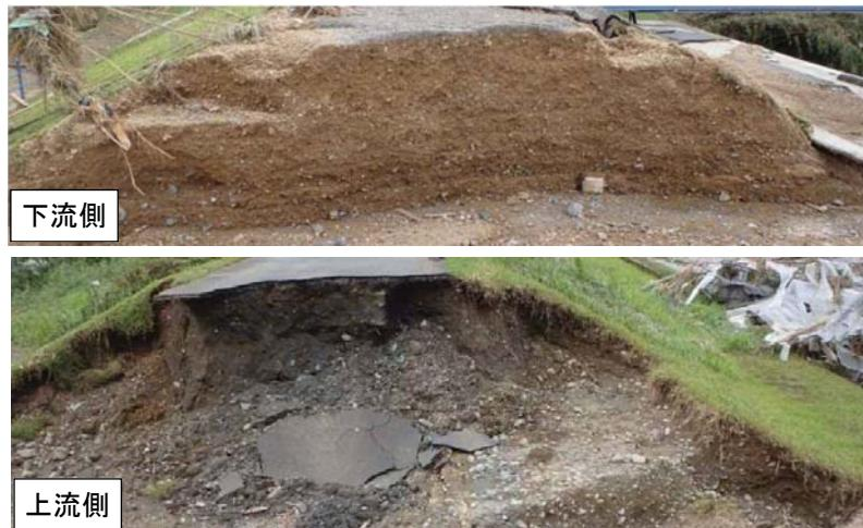
図 3.4.10 堤防決壊箇所の被災断面写真
