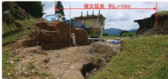
図 2.2.16 大柿排水樋管付近堤防決壊状況(55km 左岸付近)
