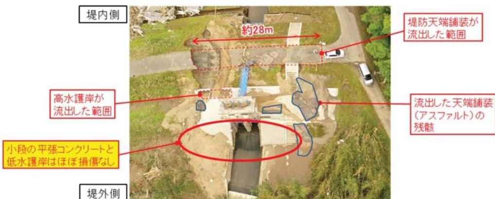
図 4.5.6 天端舗装および護岸の損壊箇所
