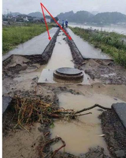
図 4.2.8(2) 被災箇所の舗装のめくれと洗掘の状況(その 2)
