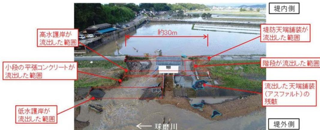
図 4.5.2 天端舗装および護岸の損壊箇所
