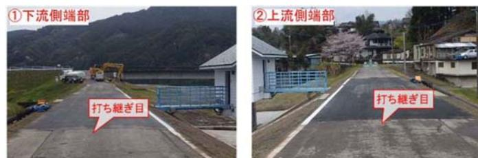
図 4.2.3 アスファルト舗装施工直後の状況写真(八久保排水樋管)
