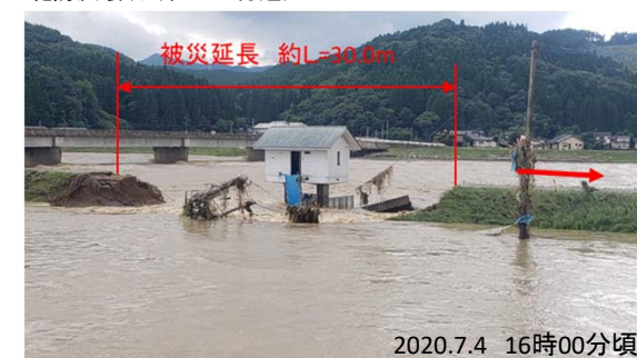
堤防損壊(右岸58.6k付近)
