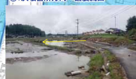
⑨：法面洗掘、電柱倒壊
