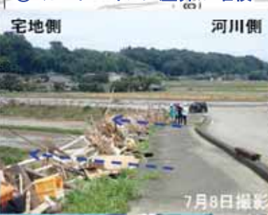
④：ガードパイプに塵芥が堆積
