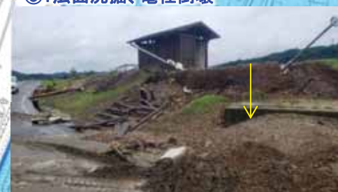
⑨：法面洗掘、電柱倒壊
