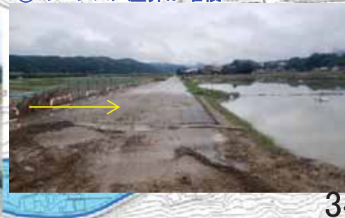
⑤：フェンスに塵芥が堆積
