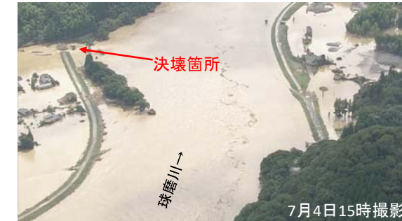
堤防決壊(右岸56.4k付近)
