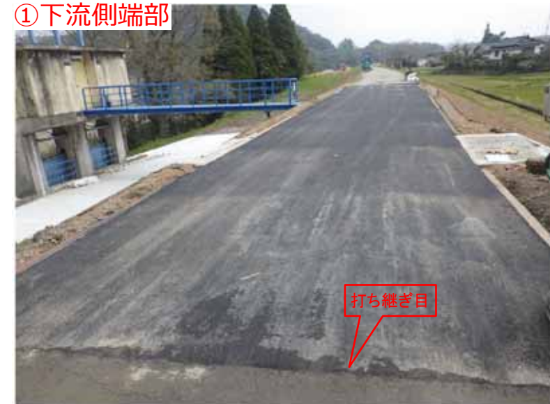
■アスファルト舗装施工直後の状況
