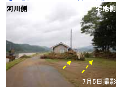
⑤: 電柱・フェンスに塵芥が堆積
