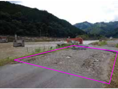
1 被災直後の状況
