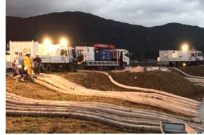
排水ポンプ車による緊急排水
