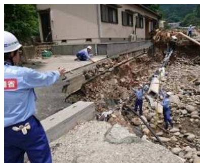
河川被害状況の調査
