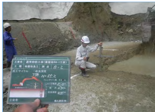
【出来形管理（杭ナビ測量）】
