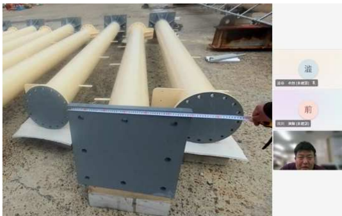
【出来形確認状況（遠景）】
