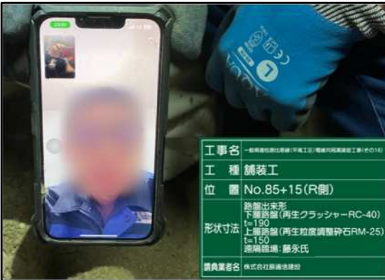
【立会状況（路盤出来形確認）】
