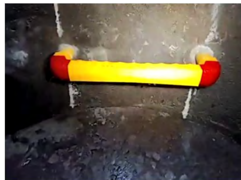
【オンライン検査（足掛金物取付確認）】
