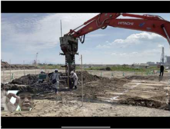
【立会状況（現場側）地盤改良工】
