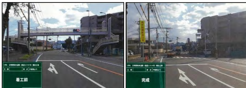
【着工前・完成】
