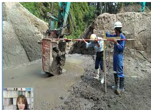
【地盤改良立会状況（現場側）】
