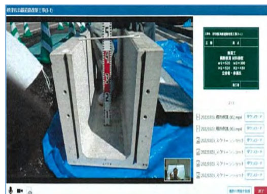
【横断側溝材料検収】
