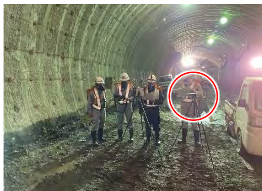
【会議用スピーカーの設置（現場側）】
