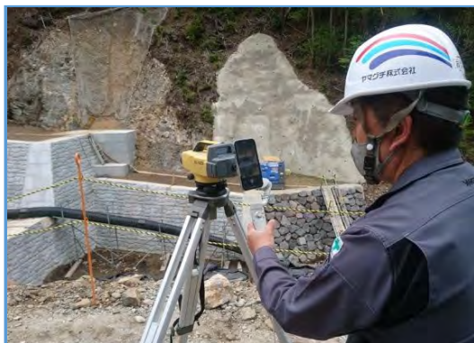
【立会状況（現場側）】
