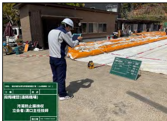
【立会状況（現場側）】
