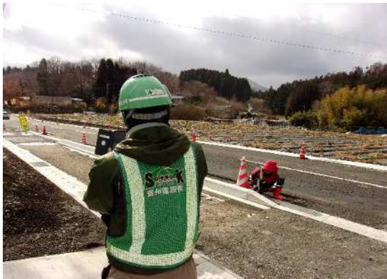
【立会状況（現場側）】
