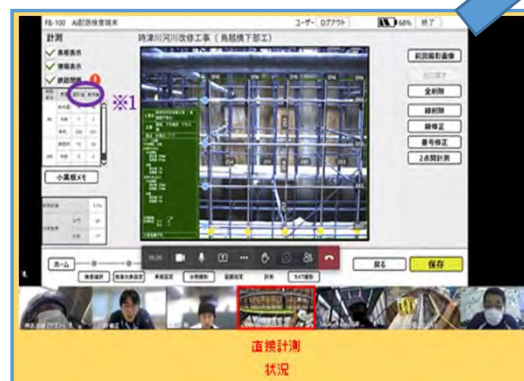
【立会状況（受発注者共有）】
