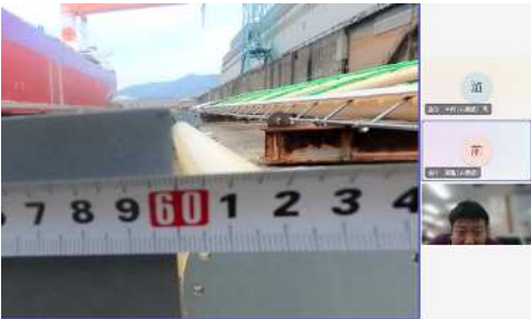
【出来形確認状況（近景）】
