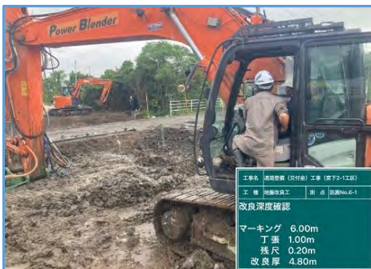
【立会状況（現場側）】
