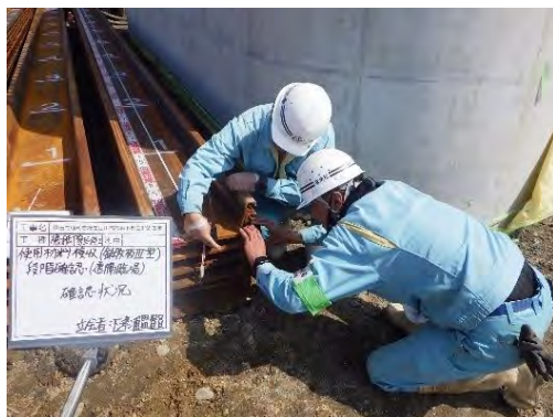
【立会状況（現場側）】
