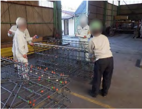
【立会状況（特殊部配筋）】
