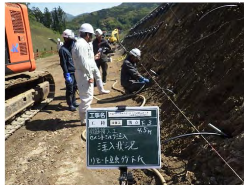
【立会状況（現場側）】
