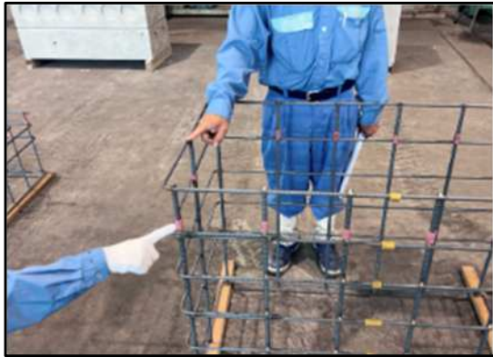
【立会状況（配筋確認）】
