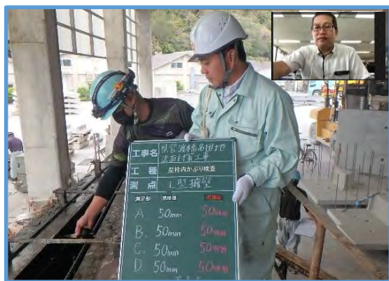
【枠内かぶり 立会状況（工場側）】
