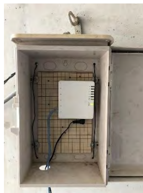
【坑内にWi-Fiルーターの設置(@100m)】
