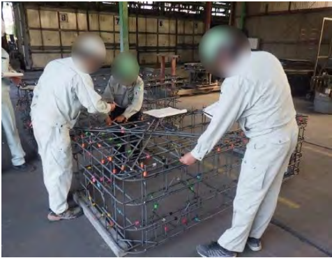
【現地状況（特殊部配筋）】
