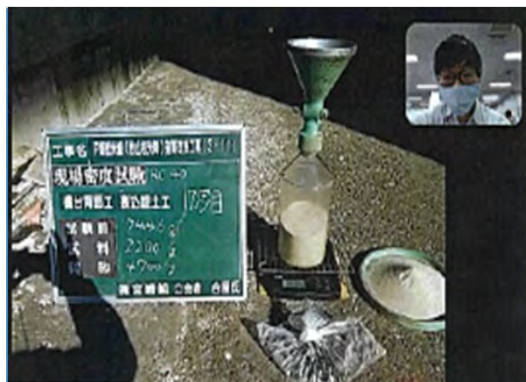
【立会状況（現場側）現場密度試験】
