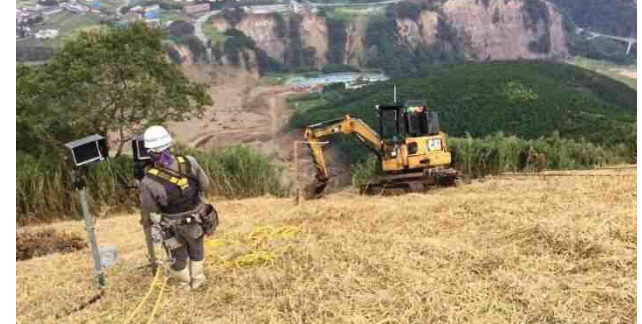
頭部ラウンディング(試験施工) (8月31日撮影)
