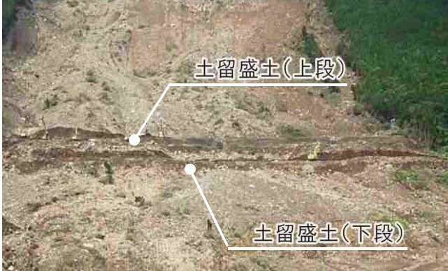
土留盛土 上段 (8月30日撮影)
