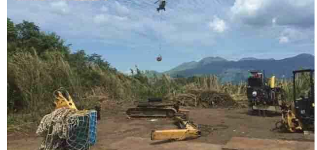
高所法面掘削機組立 (8月9日撮影)
