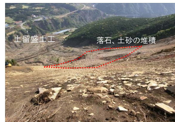
ラウンディング後の堆積状況(斜面頭部から望む)
